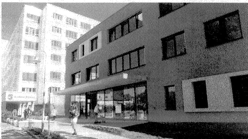
Der Gesundheitscampus wächst: Das neue Facharztzentrum ist an das Klinikum angeschlossen. Durch diese räumliche Nähe erhoffen sich die Verantwortlichen Synergieeffekte.
